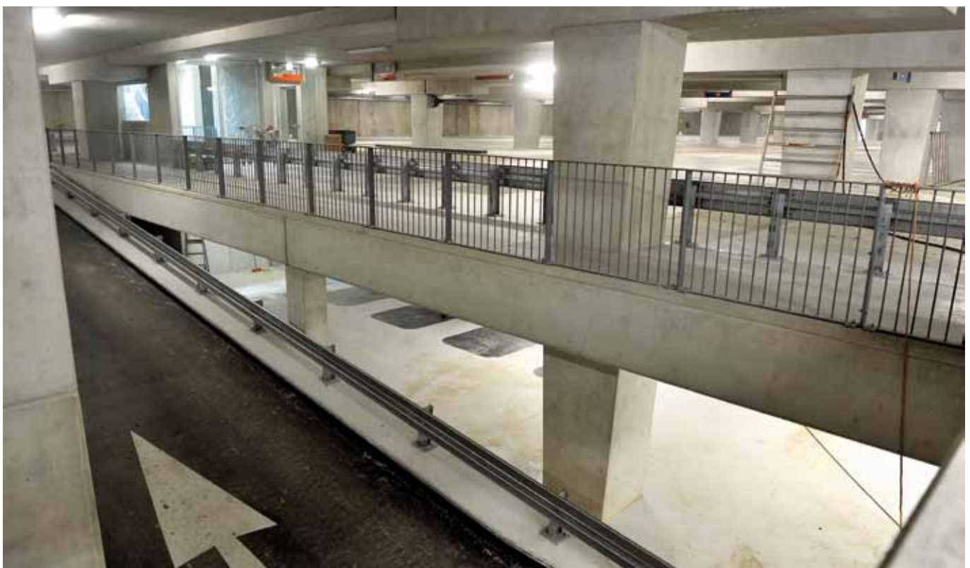
Parkeergarage Willinkplein. Foto: Jan Anninga.
